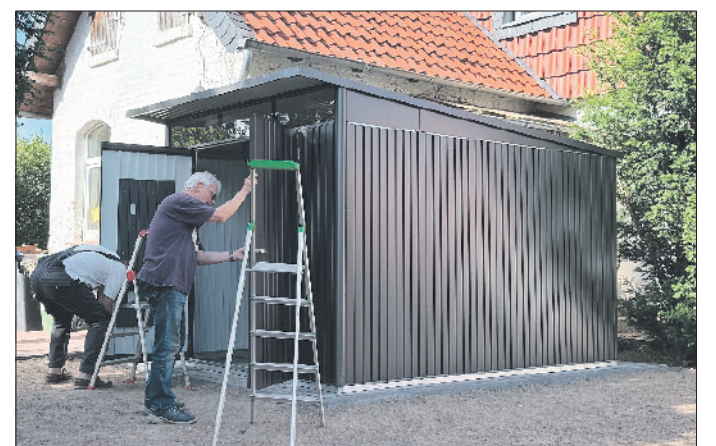
Abschlussarbeiten am Inventarraum in einer Gemeinschaftsleistung von Kulturhaus und Kirche.
