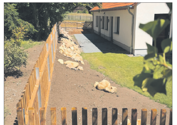
Abschluss der Zaun- und Steinmauerarbeiten
