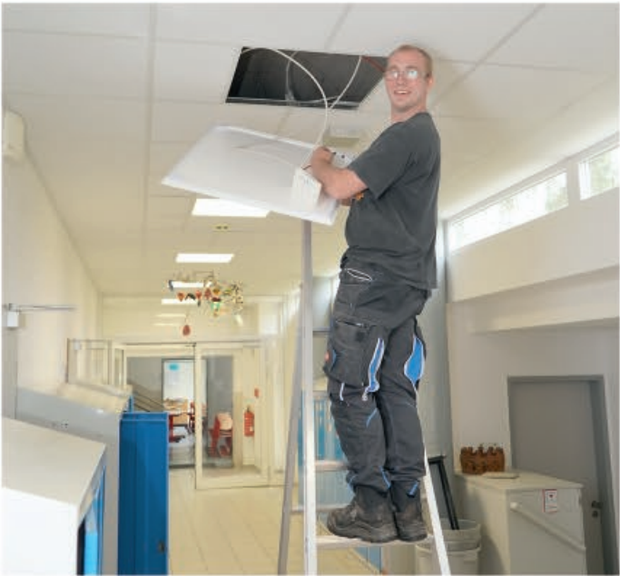
Ein Mitarbeiter des Bauwirtschaftshofs der Gemeinde Ilsede nimmt den Einbau der Beleuchtung in der Grundschule vor.
