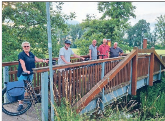
Die Brücke über den Bruchgraben wird seit Jahren von vielen Radfahrern und Fußgängern genutzt.
