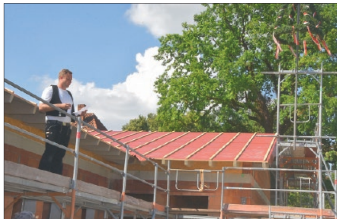
Zimmermeister Julius Oppermann erhob nach seinem passendem Richtfest-Spruch das Glas auf das Gelingen des neuen Gebäudes.
