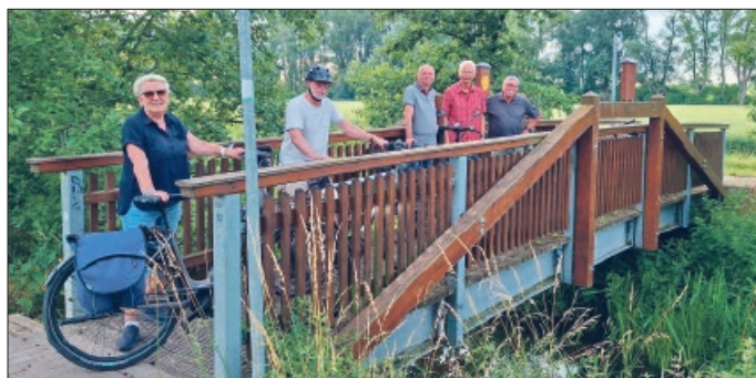
Die Brücke über den Bruchgraben wird seit Jahren von vielen Radfahrern und Fußgängern genutzt.
