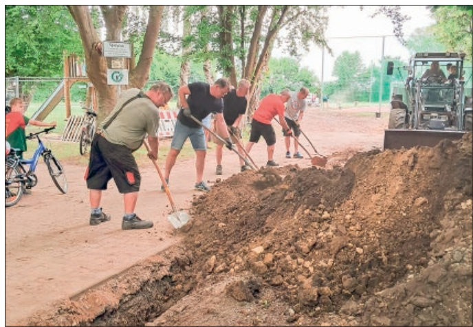
Auch eine neue Wasserleitung wurde verlegt.
