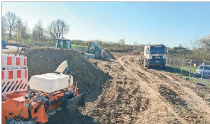
Baustraße zur neuen 60.000 Quadratmeter großen Erweiterung des Gewerbegebiets.
