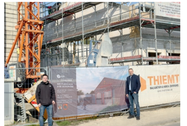
Von links: Jannik Trubjansky – Hochbau/Gemeinde Holle und Bürgermeister Falk-Olaf Hoppe bei der Begutachtung des Baufortschritts
