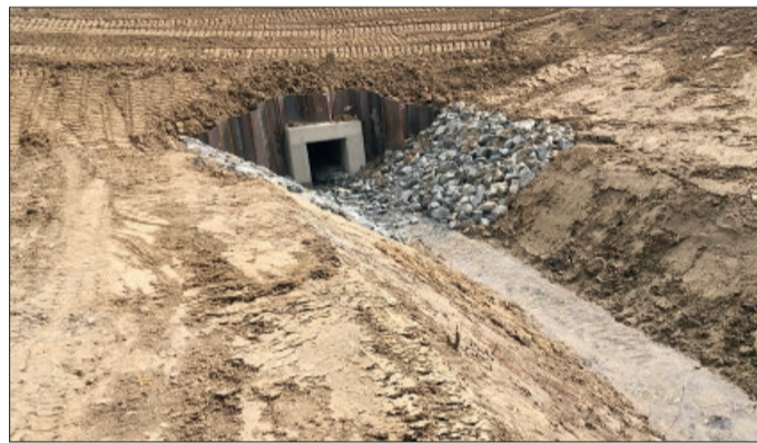
Regenrückhaltebecken zwischen Hackenstedt und Sottrum
