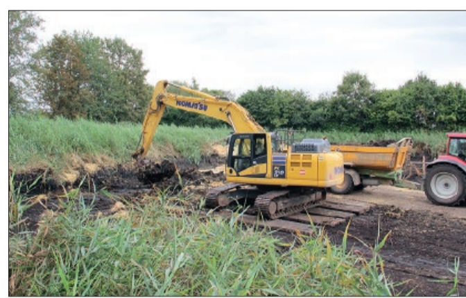
Das benachbarte Beet in Soßmar wurde 2024 geräumt – ein ähnliches Bild wird sich auch jetzt wieder zeigen: Der Bagger gräbt die Klärschlamm-erde mit Schilf ab und verläßt sie.
