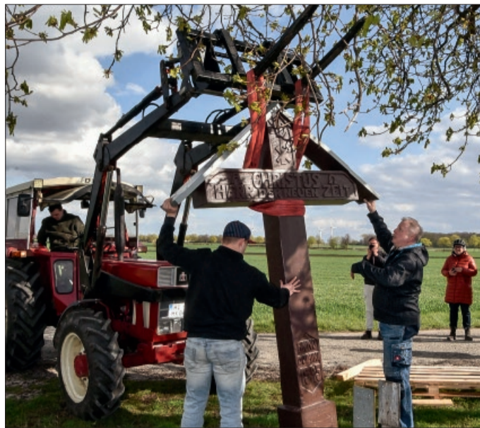
Mit Hilfe des an der Treckergabel hängenden Kreuzes wurde es in die Halterung geschoben.
