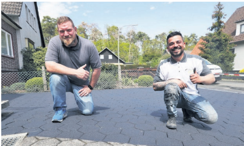
Eine mit dem Steinfresh®-Verfahren sanierte Pflasterung. Das geniale Pflegesystem verhindert Flechten und Schwarzalgen.
