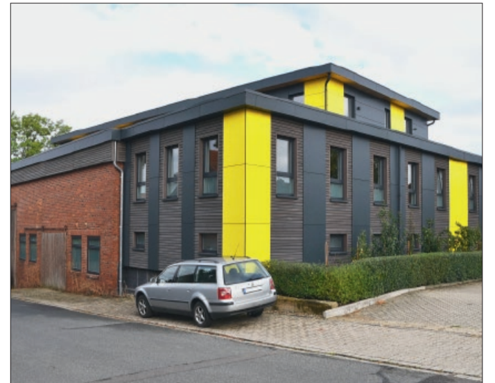
Der schicke Neubau wurde auf der Südseite angebaut. Links noch der alte steinerne Gebäudeteil.
