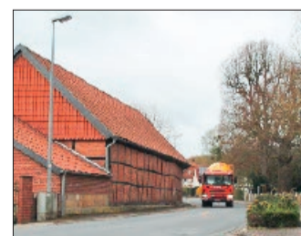
Die Dorfstraße Hildesheimer Straße in Grasdorf.
