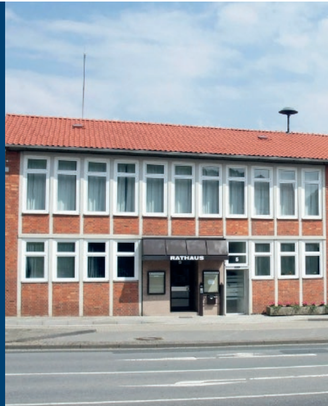
Rathaus und Grundschule an der Alfelder Straße in Diekholzen.
