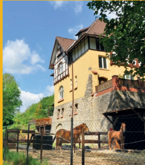
Ehemaliges Pförtnerhaus des Schachtes Hildesia.
