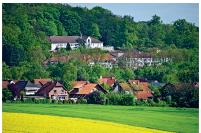
Blick auf das Baugebiet Heideweg und die ehemalige Lungenklinik.
